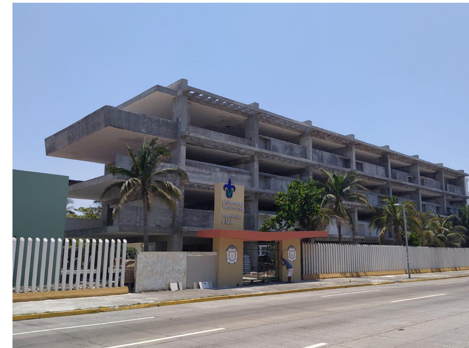
Construcción de nuevos edificios
