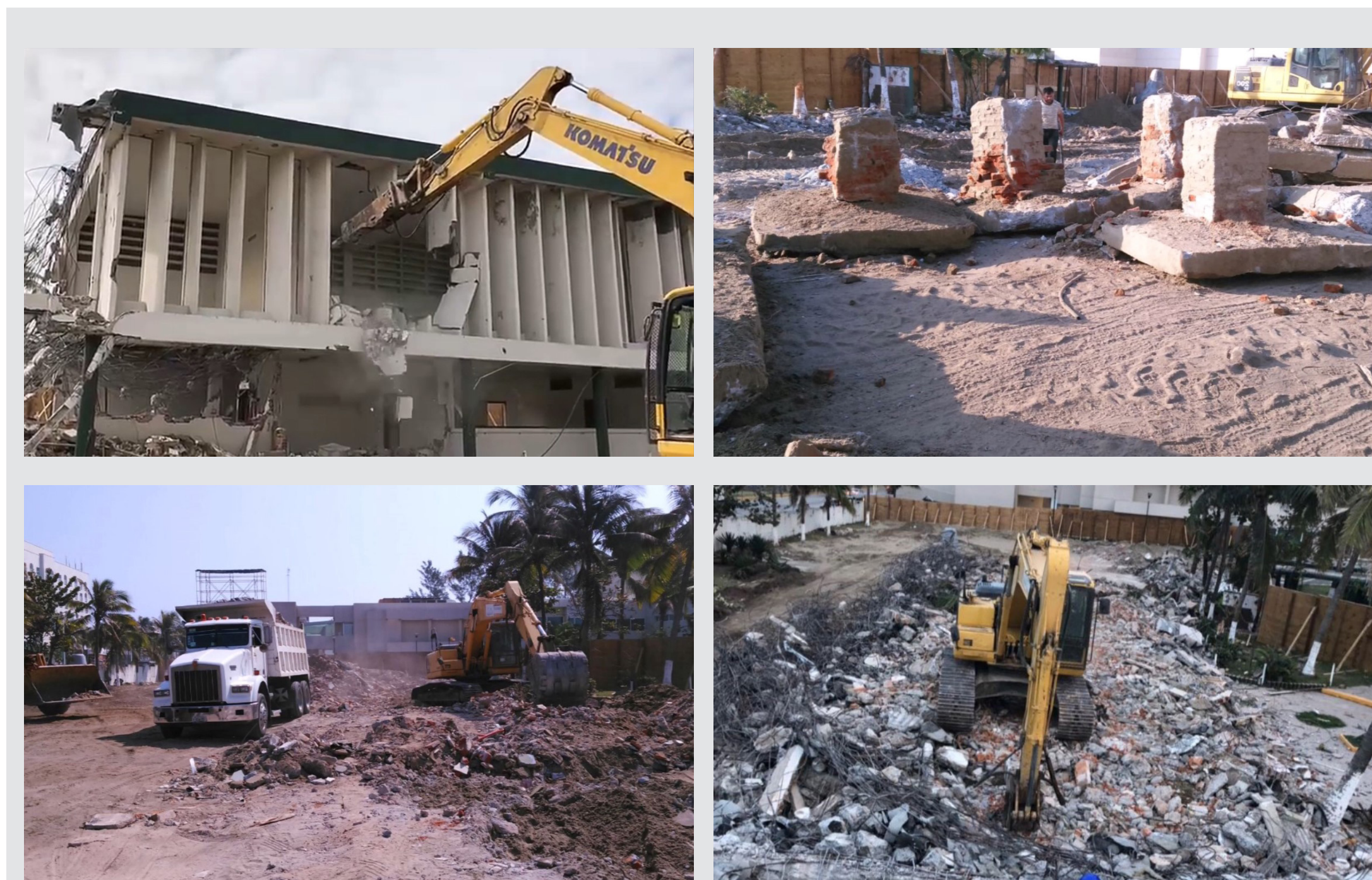
Demolición de edificios existentes
